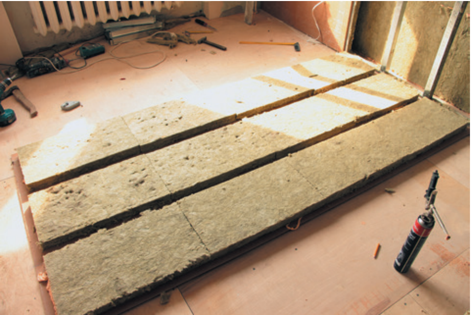
Звукоизоляционная «стена» из гипсокартона Knauf Diamant и минеральной ваты AcousticWool Sonet 48 кг/м³
