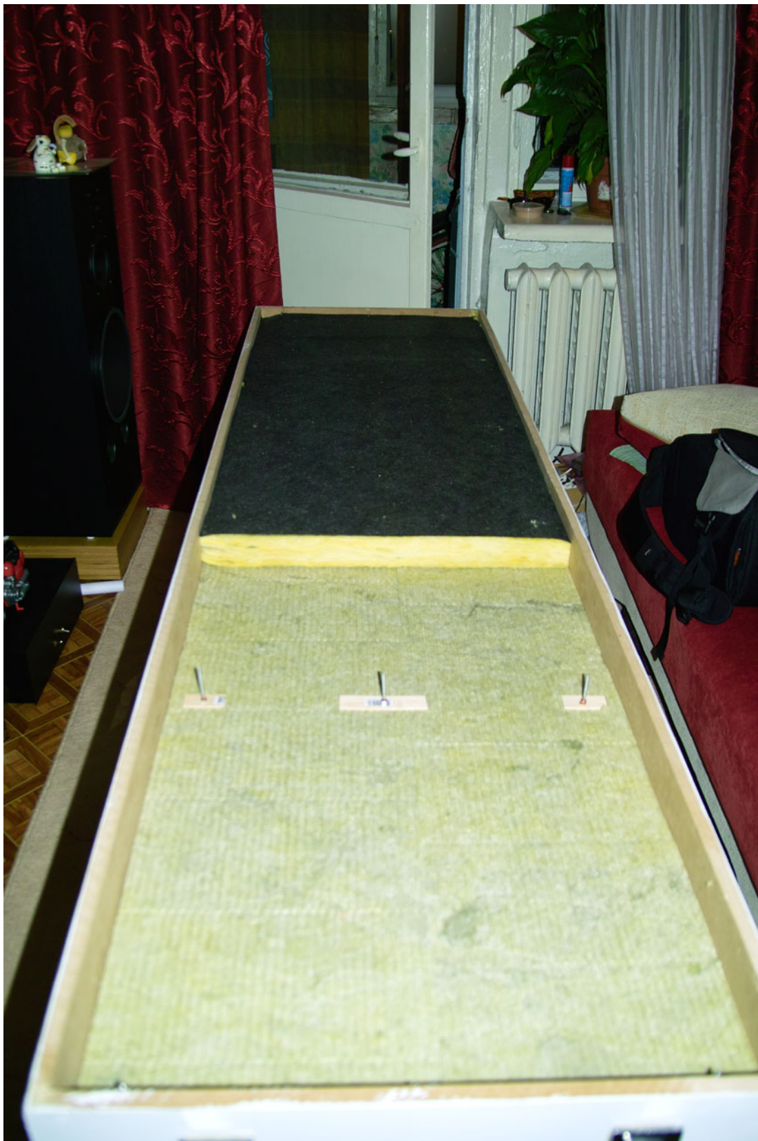
Фотография уложенным вторым слоем Шуманет СК.
